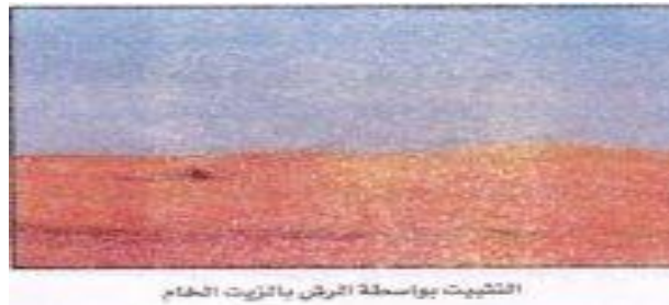
التثبيت بواسطة الرش بالزيت الخام
